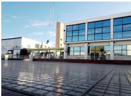
Paseo peatonal de la Municipalidad
