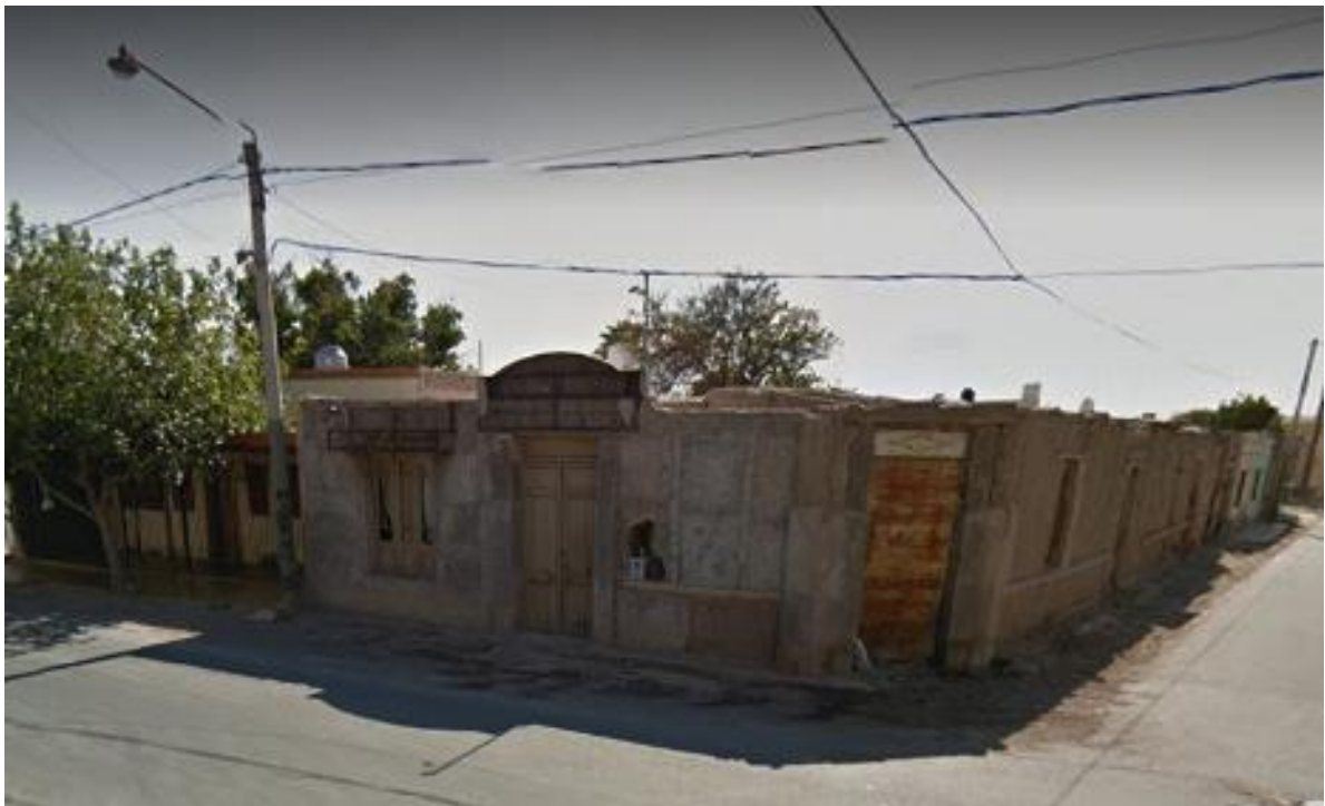
Foto N° 4: Se pueden observar viviendas con mala calidad constructiva
