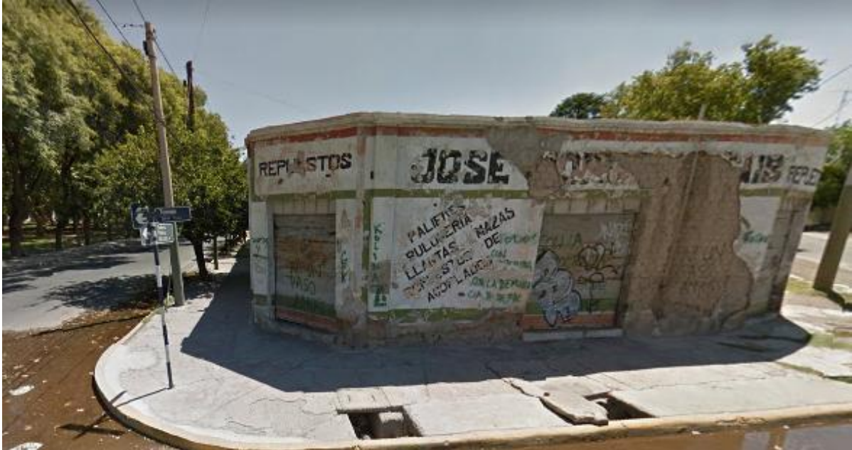
Foto N°5: Imagen de construcción blanda y residuos líquidos en la vía
