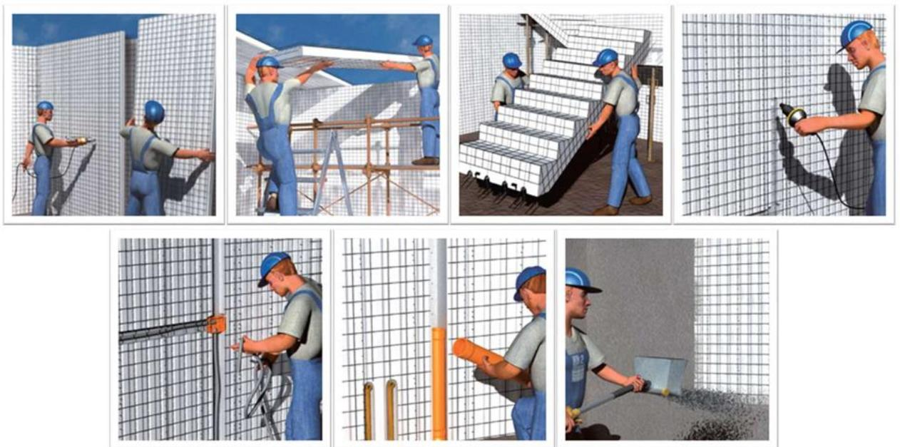
FOTO 58: Proceso constructivo Steel Frame
