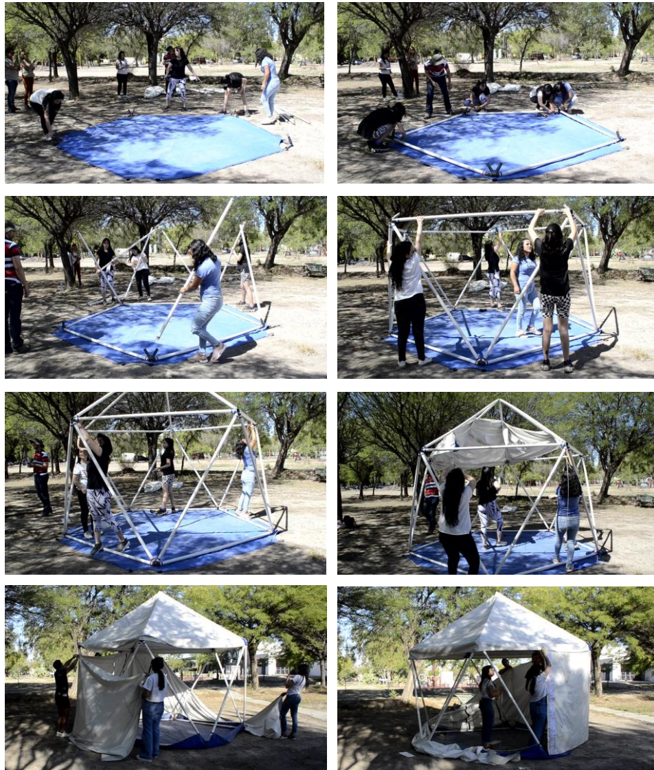
Figura 25: Ensayo del Armado del MTP.
