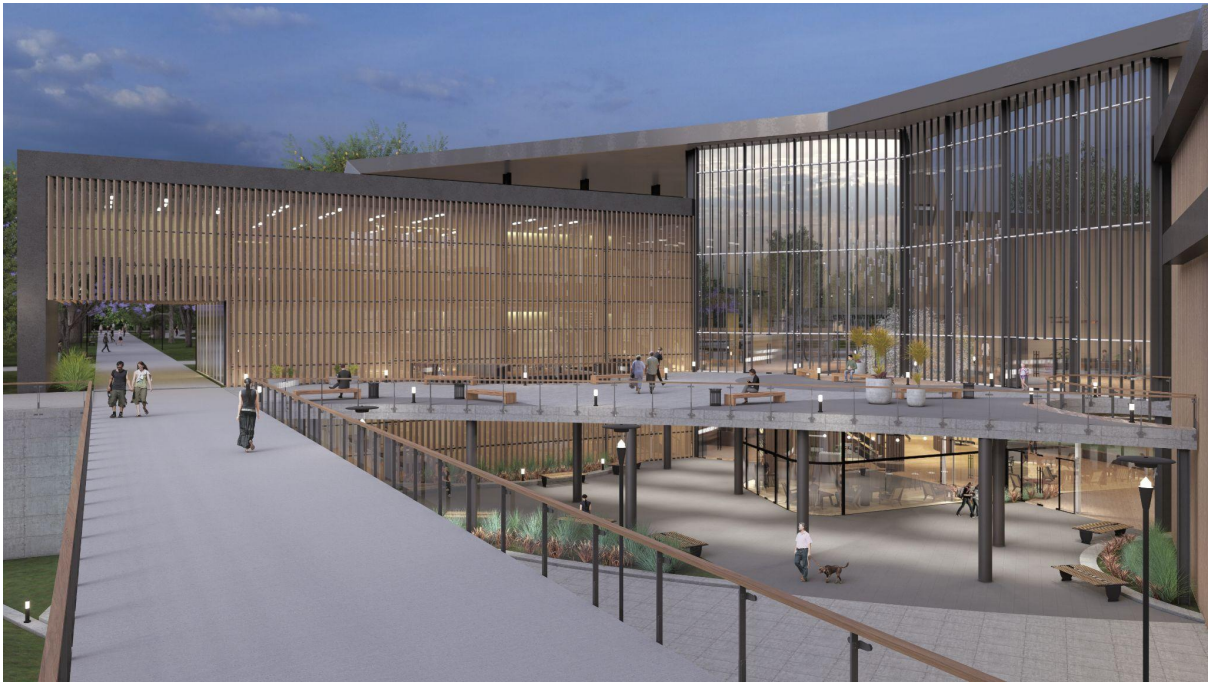
Acceso peatonal Este desde puente
