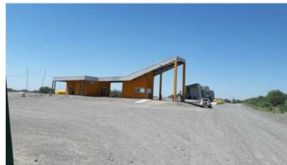
FOTO Nº4: oficina de controles
