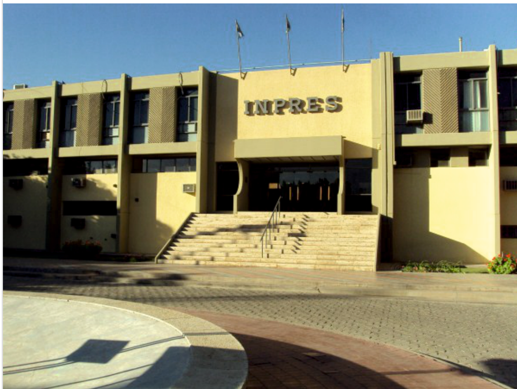
Edificio central del INPRES
