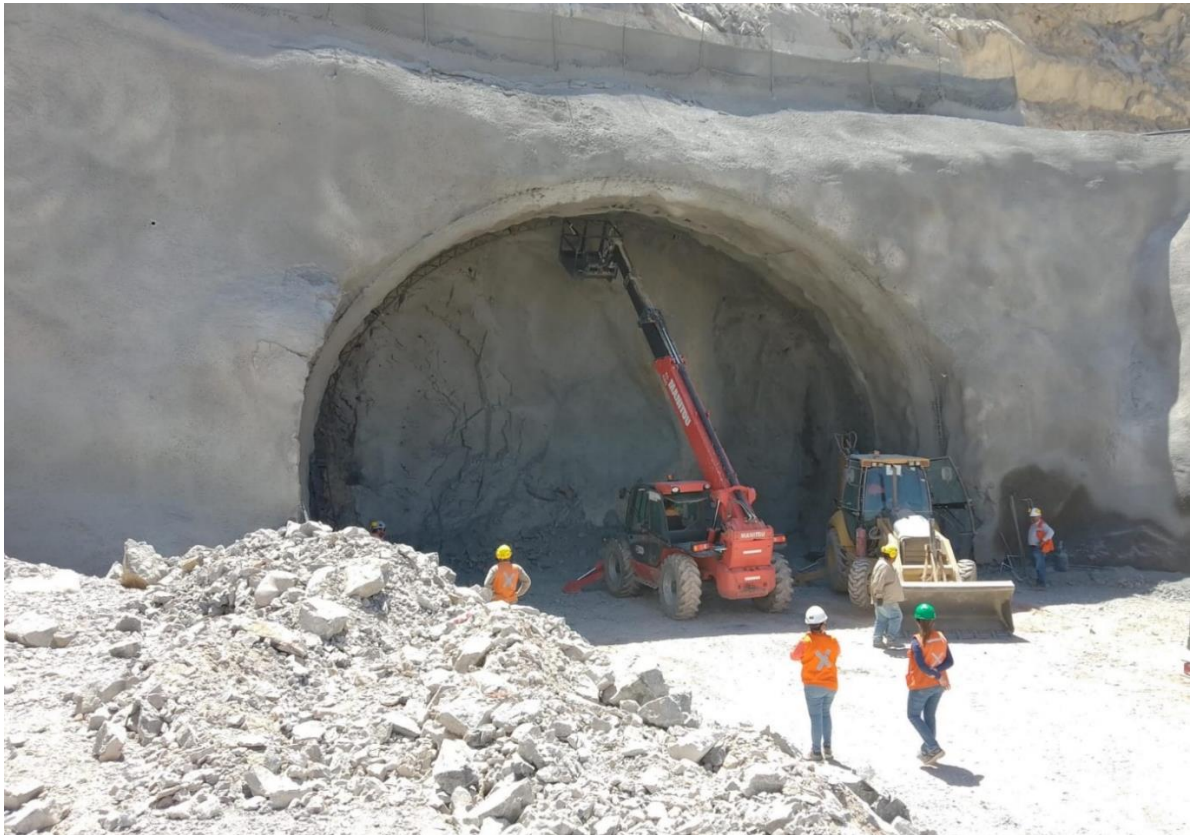
Figura 111. Máquina elevadora posicionando la cercha en el frente de excavación (imagen del portal Rivadavia).
