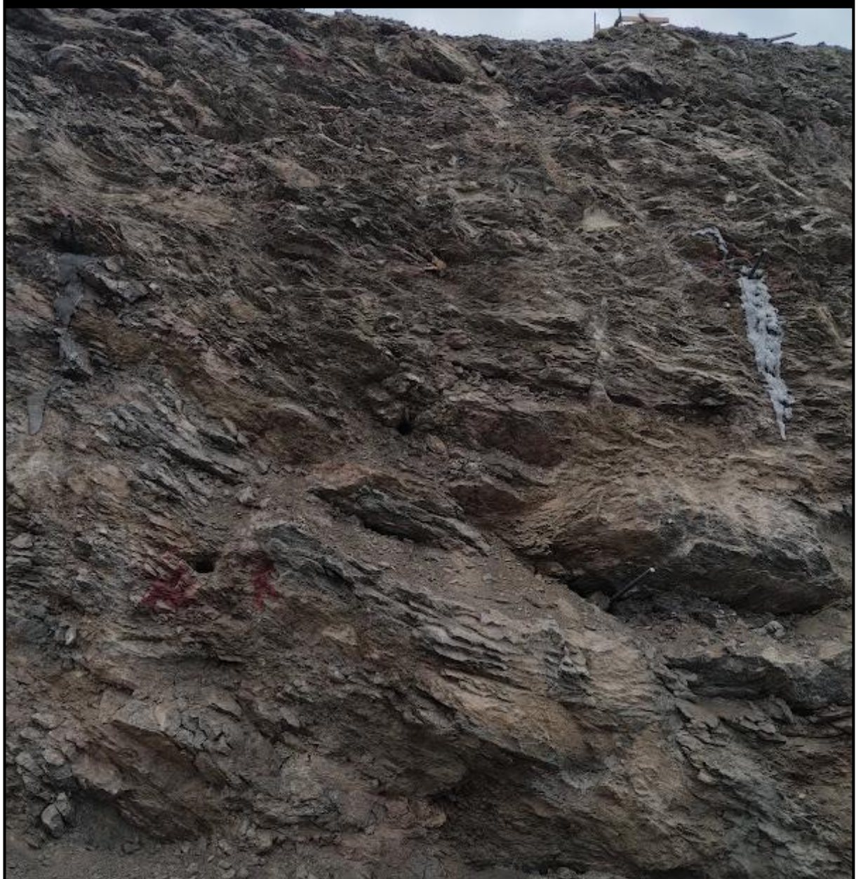
Figura 46. Imagen de la Estación Geomecánica 2. En la fotografía superior se señala su ubicación.
