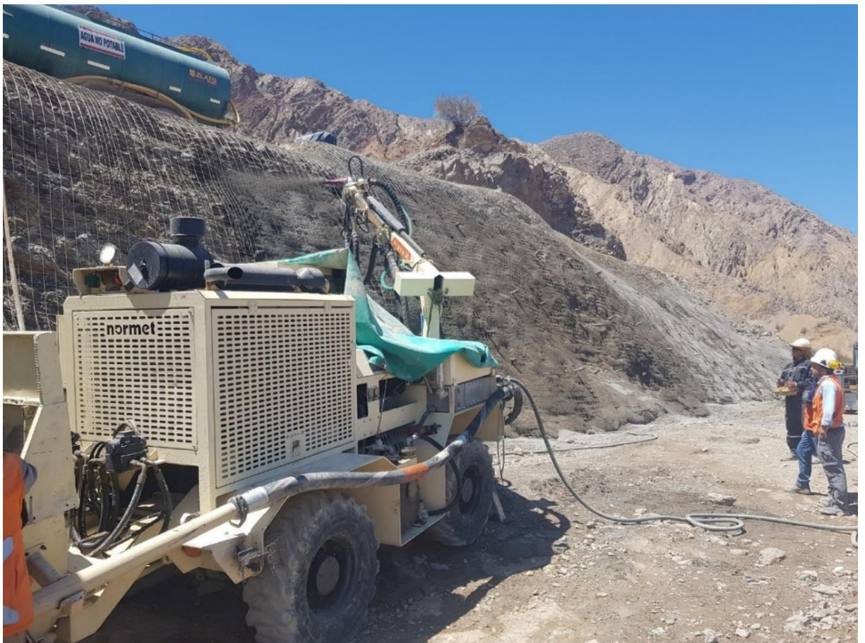
Figura 110. Máquina proyectando el hormigón sobre el talud, cubriendo las mallas.
