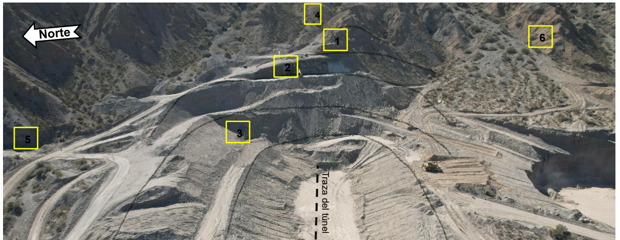
Figura 37. Vista general del portal Zonda. Se observan los principales taludes (en construcción) y se señalan las estaciones geomecánicas relevadas.
