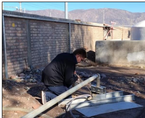
Figura 6.7: Ensayo de bombeo en La Salmuera
