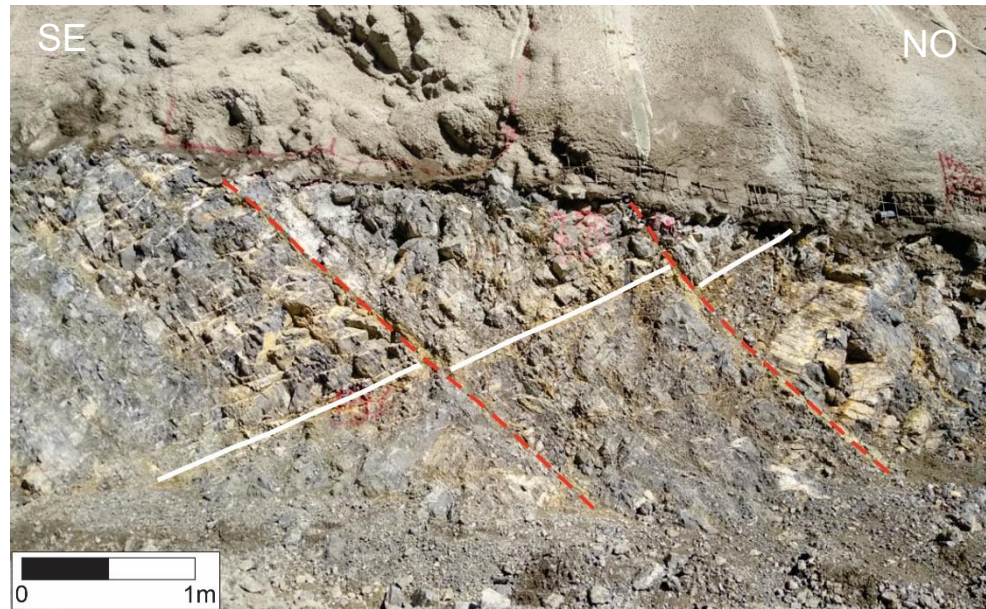
Figura 3.48: En la imagen se indica con trazos discontinuos de color rojo las dos fallas sobre el talud, con trazos continuos de color blanco se indica el desplazamiento en los planos de estratificación.
