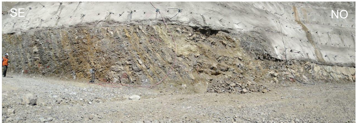
Figura 4.28: Imagen de la ventana 04 en el talud de cota 1239-1233.
