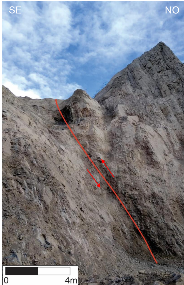
Figura 3.27: Se indica con trazo continuo de color rojo la posición de la falla sobre el talud.
