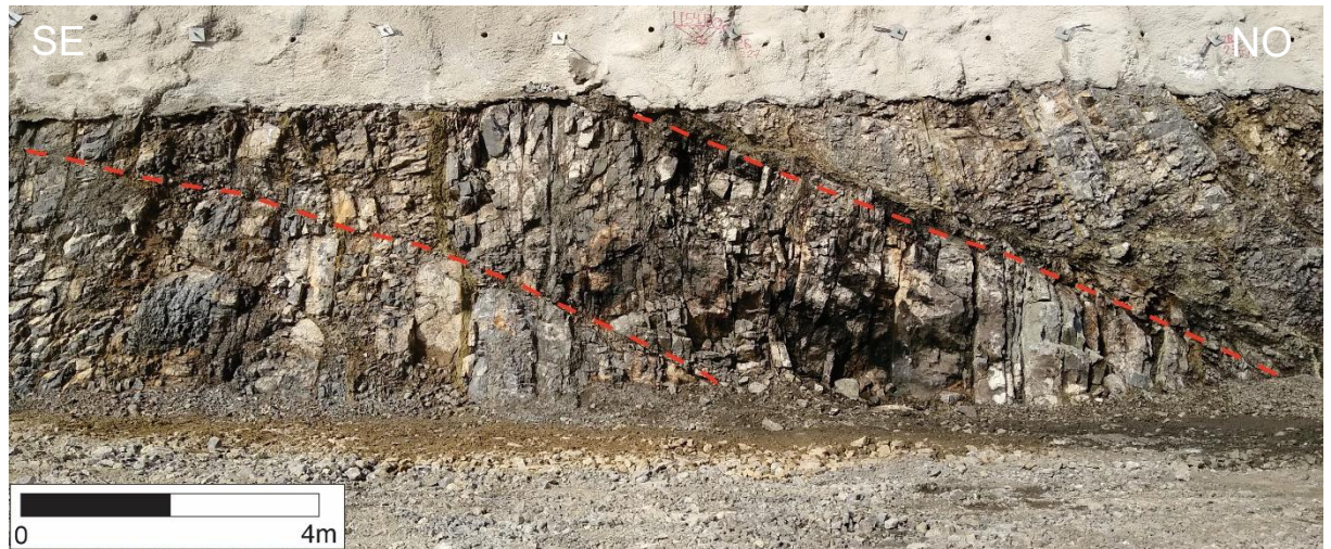
Figura 1.7: imagen del talud del plinto sobre la cota 1140m en el margen derecho, donde se observan estructuras de fallamiento inverso (líneas rojas) rellenas de arcillas, las cuales producen alteración rica en óxidos de manganeso y hierro.
