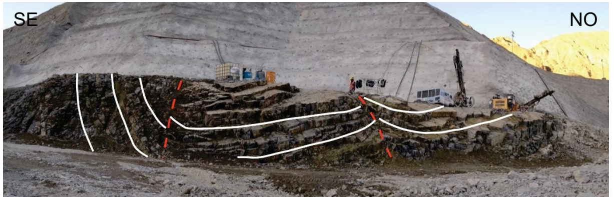
Figura 3.57: Se indican con trazos continuos de color blanco los planos de estratificación y con trazos discontinuos de color rojo las dos fallas locales.
