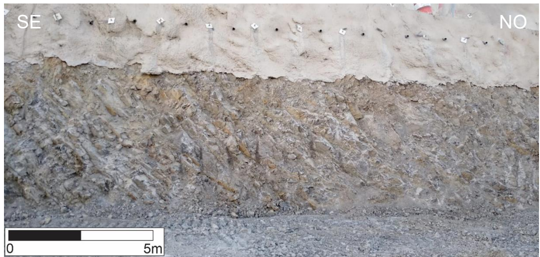
Figura 4.42: Imagen del talud entre las cotas 1200m a 1210m donde se relevó la ventana 06.
