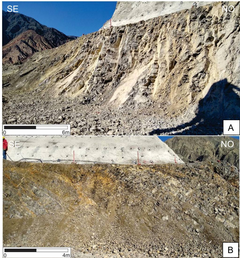
Figura 3.53: En (A) se observan los flancos verticales del pliegue sinclinal al SE en la zona de remate del talud. En (B), se observan los planos de estratificación con alteraciones de óxidos de hierro.
