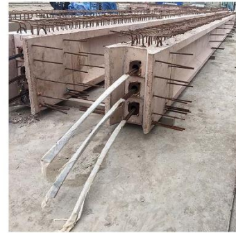
Gráfica N°42: despiece de elementos estructurales polideportivo. Placas tipo pi n50. Vigas tipo I Prefabricadas.
