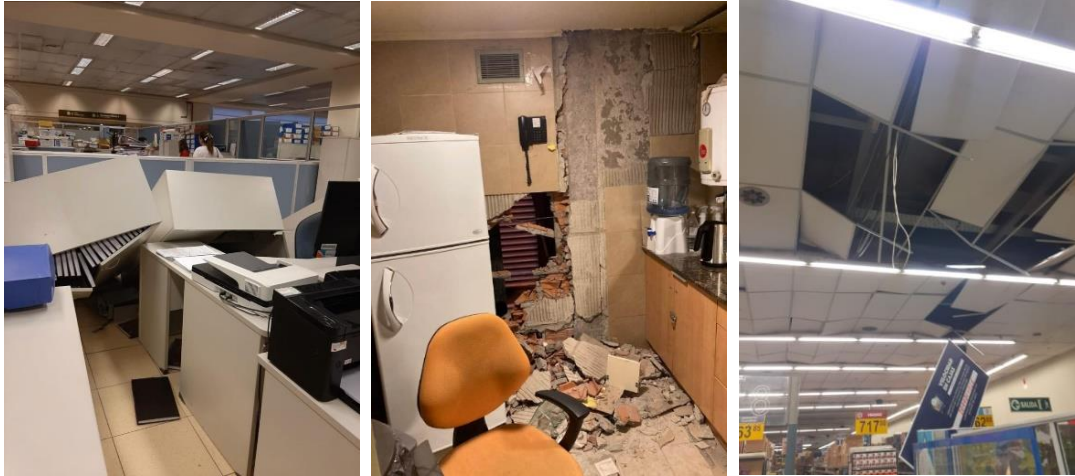
Foto 1 y 2: Daños en el Centro Cívico. Foto 3: Daños en supermercado Vea – Fuente: https://www.diariodecuyo.com.ar
