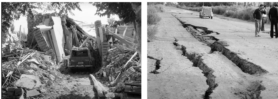
Fotos 12 y 13: Imágenes luego del terremoto de 1977 en Caucete. Fuente: https://www.youtube.com/watch?v=XHx7LjvoqOo&feature=emb_logo
