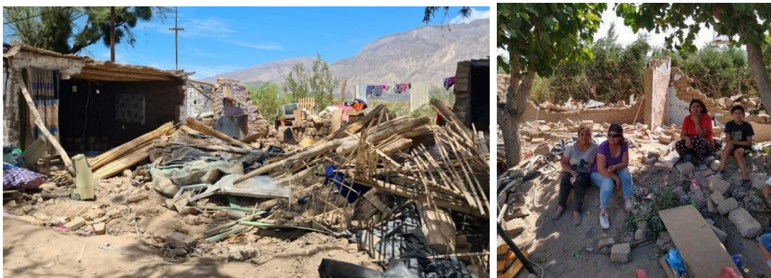
Foto 4 y 5: Daños en viviendas – Fuente: https://www.diariodecuyo.com.ar
