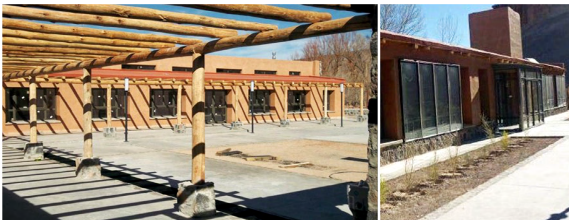
Figura 9. Colegio Secundario N°39, Catamarca. Izquierda: Sector aulas con galería/invernadero, orientado al norte. Derecha: muro Trombe en dormitorios. Fuente: Walter et al., 2016.
