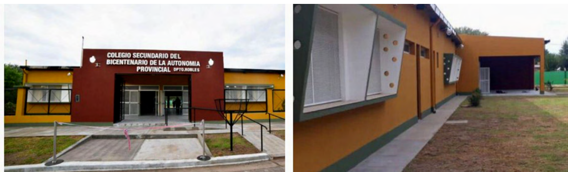
Figura 1: Colegio Secundario del Bicentenario de la Autonomía Provincial, Vilmer, Santiago del Estero. Izquierda: Portal de acceso. Derecha: Vista del diseño de aberturas. Fuente: UNSE (2024).
