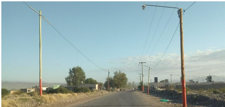
Calle Díaz al norte de calle 25 de Mayo- Registro Propio
