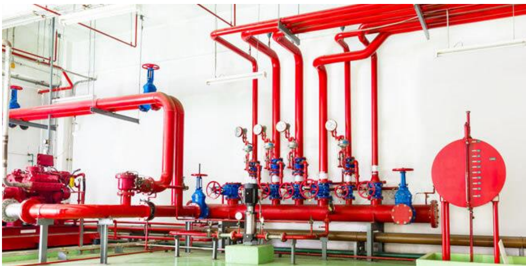
Instalación de sistema contra incendios, Cañerías de conexión.
