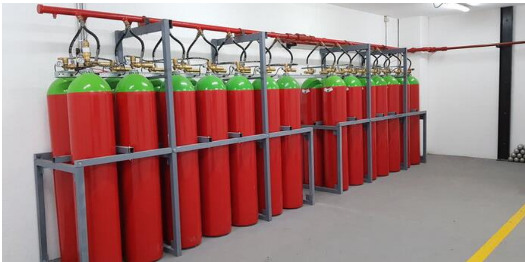
Instalación de dos baterías de 140L 300 bar. Colector y soportería de fabricación in situ.
