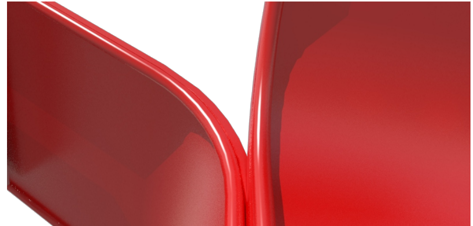
Refuerzo de la chapa con hierro curvado y soldado.
