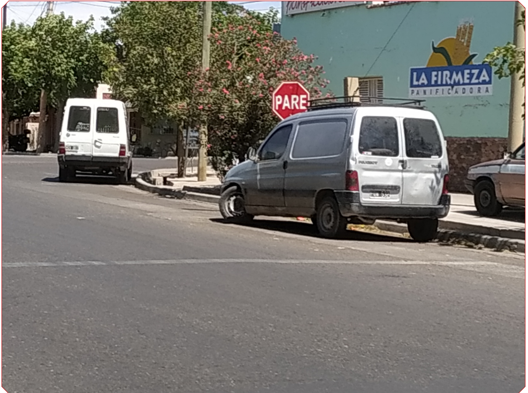
Exploración de Campo, en las calles sanjuaninas. Señales verticales de muy baja altura y horizontales desgastadas.
