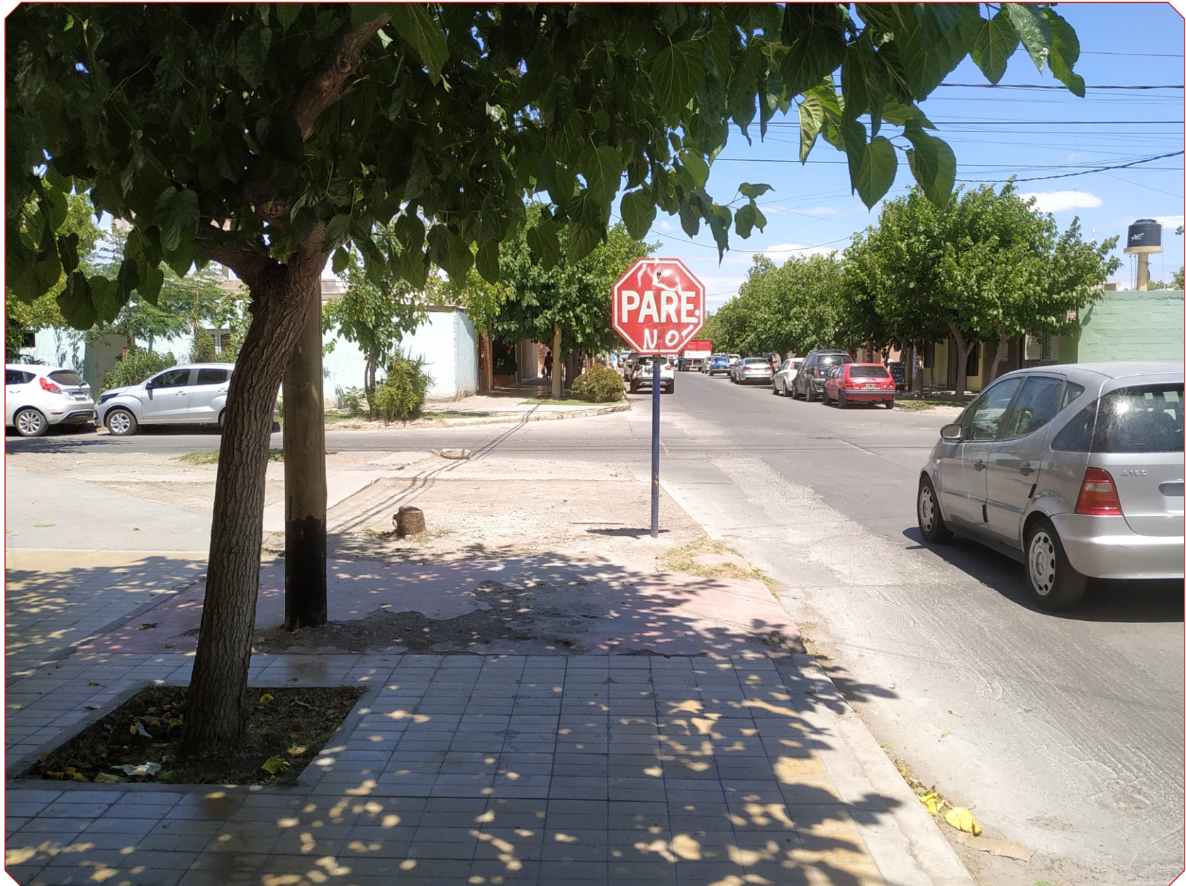
Señales de transito Vandalizadas, con altura deficiente..
