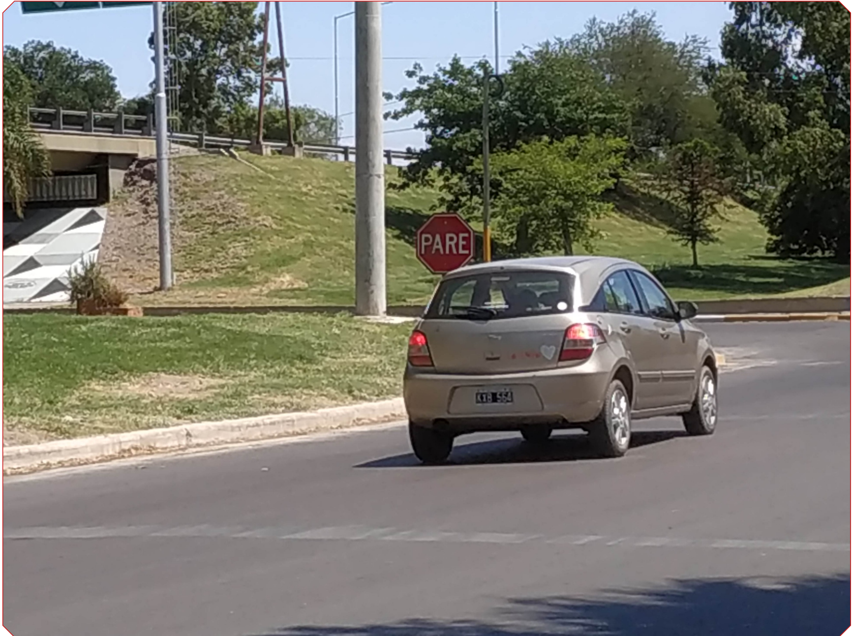
Exploración de Campo, en las calles sanjuaninas. señal de baja altura. no alcanza la altura mínima.
