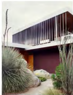
Foto 3 - Terminación de color bordó del muro exterior de la pérgola cubierta.
