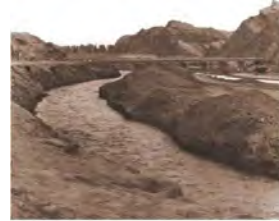
1972. Desvío del río San Juan, para la construcción del Dique de Ullum y al fondo se observa el puente que unía Ullum con la Capital.
