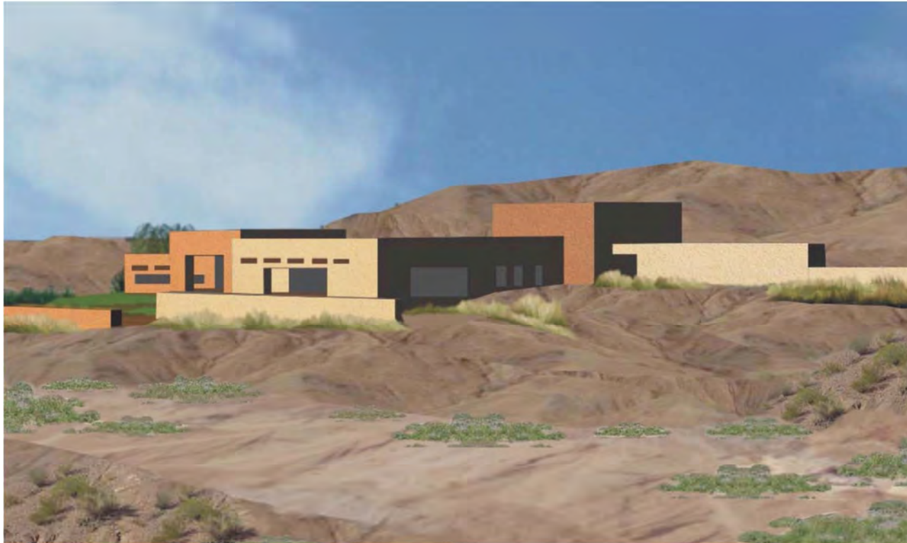
Vista general del conjunto (áreas de acceso, administración, social y terapia).
