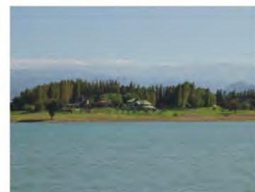
Vivienda de fin de semana, Dique de Ullum. Ubicación geográfica: 31°26'31"S - 69°40'30"W
