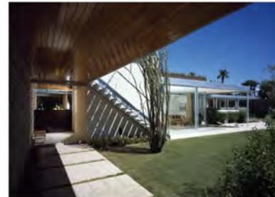
Foto 4 - Vista de la pérgola cubierta en voladizo que conduce al acceso de la casa.
