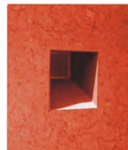
Mampostería de acabado Stucco Rustico
