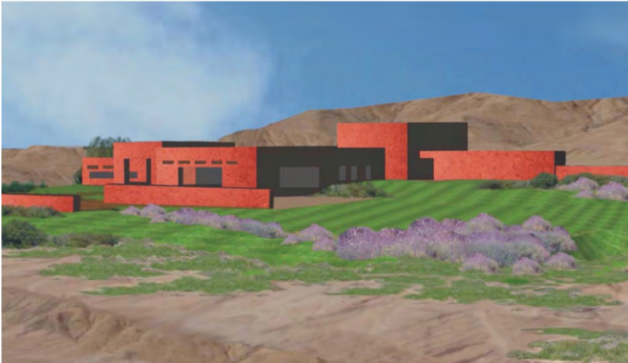
Vista general del conjunto (áreas de acceso, administración, social y terapia).
