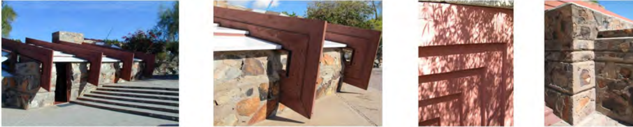
Foto 8 - Vista del estudio y detalle de vigas, cubierta, carpintería y mampostería.
