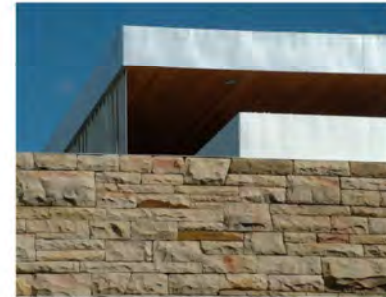
Foto 8 - Detalle de sillares de piedra y estructura de madera y acero.
