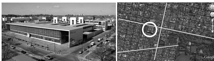
Figura N° 76: Hospital ubicado en el encuentro de vías vehiculares principales. Hospital de Emergencias Clemente Álvarez (HECA), Arq. Mario Corea y Asoc. Rosario, Argentina. (SUMMA, 2008: 13)
