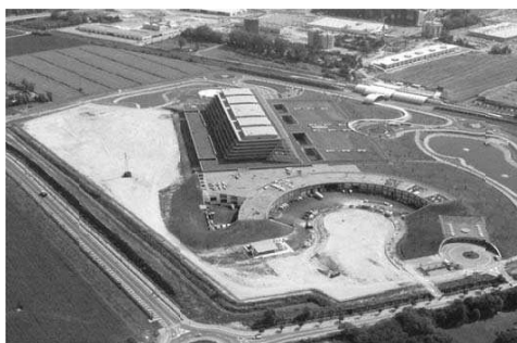
Figura N° 77: Hospital ubicado en el encuentro de vías vehiculares principales. Hospital en Mestre, de Studio Altieri y Prof. Ach. Emilio Ambasz. Venecia, Italia. (BROTO, 2009: 55)
