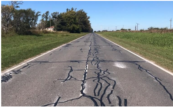
Sellado de grietas con asfalto.
