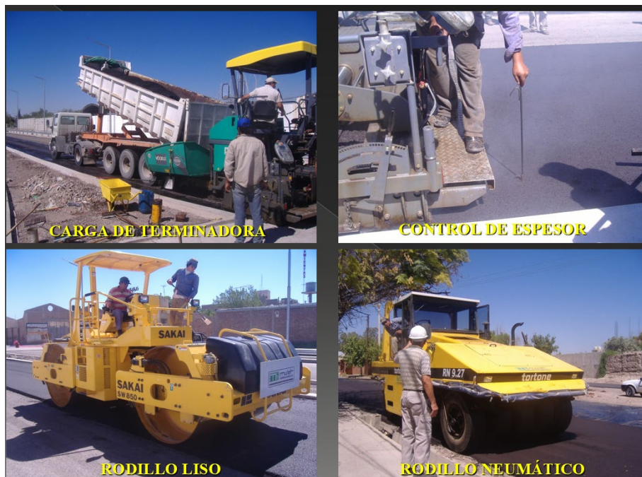
Pasos de construcción de Pavimento Flexible.
