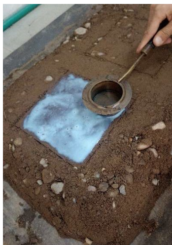
Colocación de emulsión pura.
