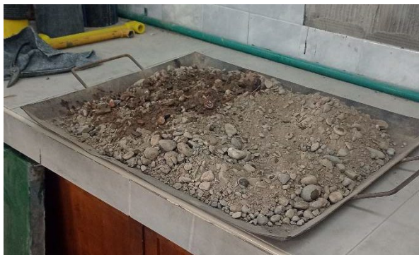
Material pétreo antes de humectado y compactado.
