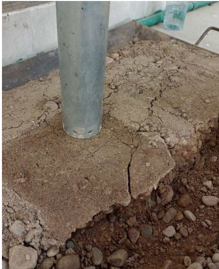
Caída de pisón para generar fisuración y rotura.
