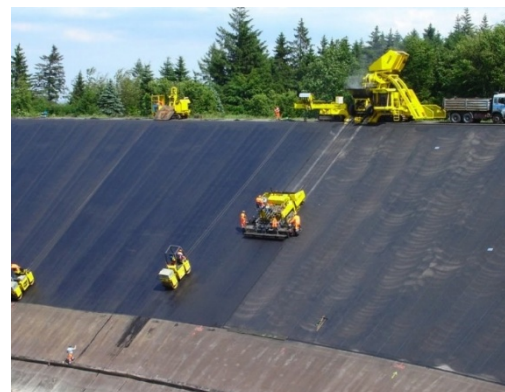
Impermeabilización de presa con emulsión.
