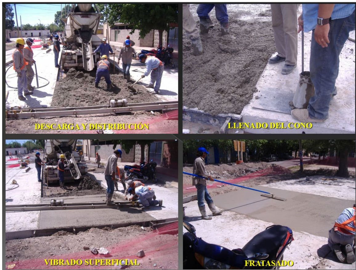
Pasos de construcción de Pavimento Rígido.
