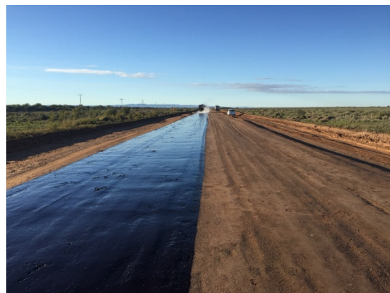
Riego de Imprimación con asfalto en media calzada.
