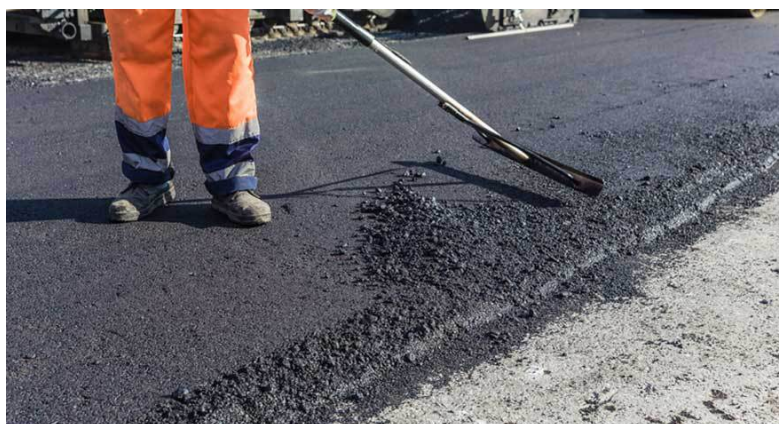
Distribución de Concreto Asfáltico en caliente.
