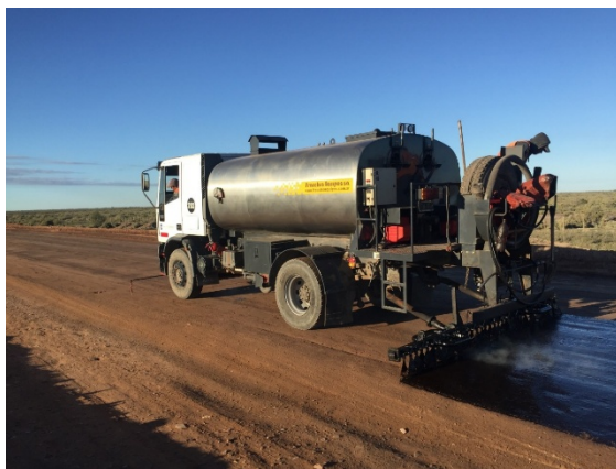
Camión regador aplicando emulsión en media calzada.
